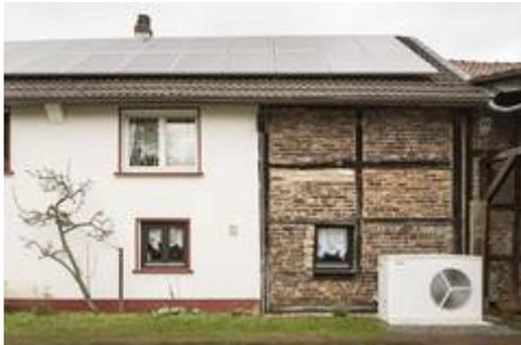
Moderne Wärmepumpen eignen sich mittlerweile optimal für die Sanierung. Die Kombination mit einer Photovoltaikanlage, die unter anderem den Strom für den Betrieb der Luft-Wasser-Wärmepumpe liefert, macht den Einsatz doppelt wertvoll. Regenerative Energien werden für Warmwasser und Heizung genutzt, zugleich ist der Nutzer so unabhängig wie möglich von den Energieversorgern. Bild: tdx/Stiebel Eltron
