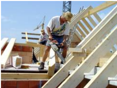
Eigenleistungen können die Investition in ein Eigenheim spürbar reduzieren. Allerdings sollten Dachdecker- und Zimmererarbeiten noch immer dem Fachmann überlassen werden. Bild: tdx/RGBuW
